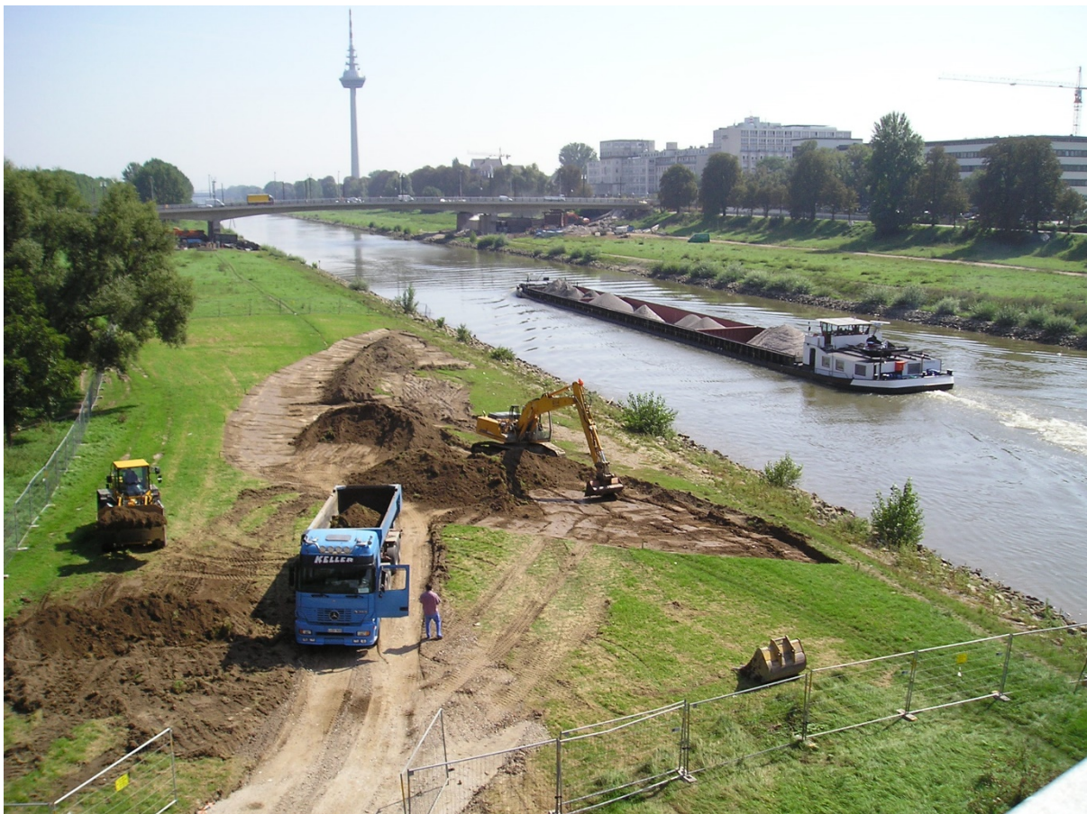
Abb. 2: Baubeginn der Flachwasserzone in Mannheim.
