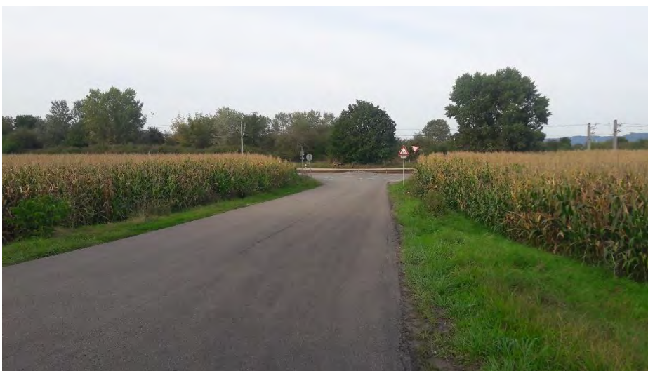
Abbildung 2.3: Blick von Süden entlang Bärlochweg
